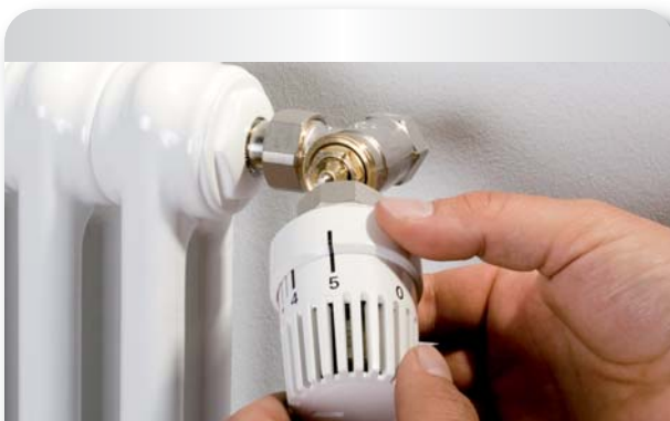
Prüfen der Voreinstellung an einem Thermostatventil
