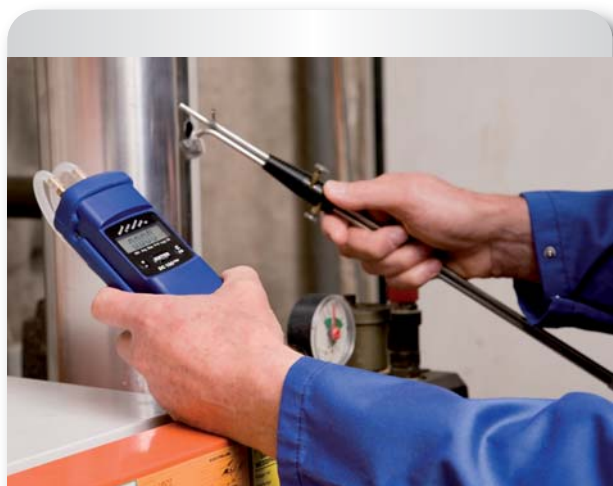
Messung am Wärmeerzeuger
